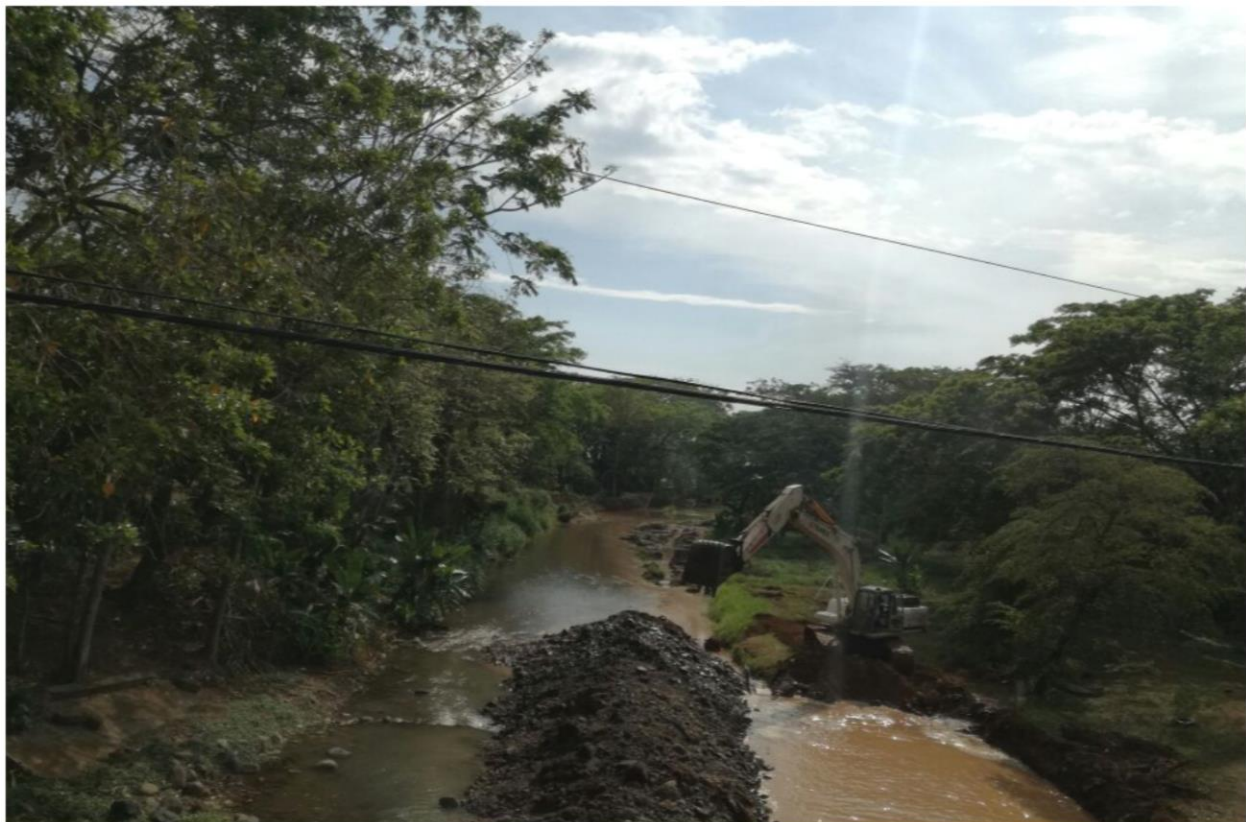
La imagen corresponde a trabajos de recava en río.
