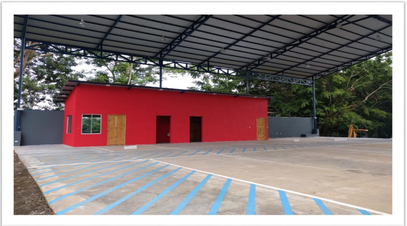
La imagen corresponde a la infraestructura del Centro de Valorización de Materiales.
