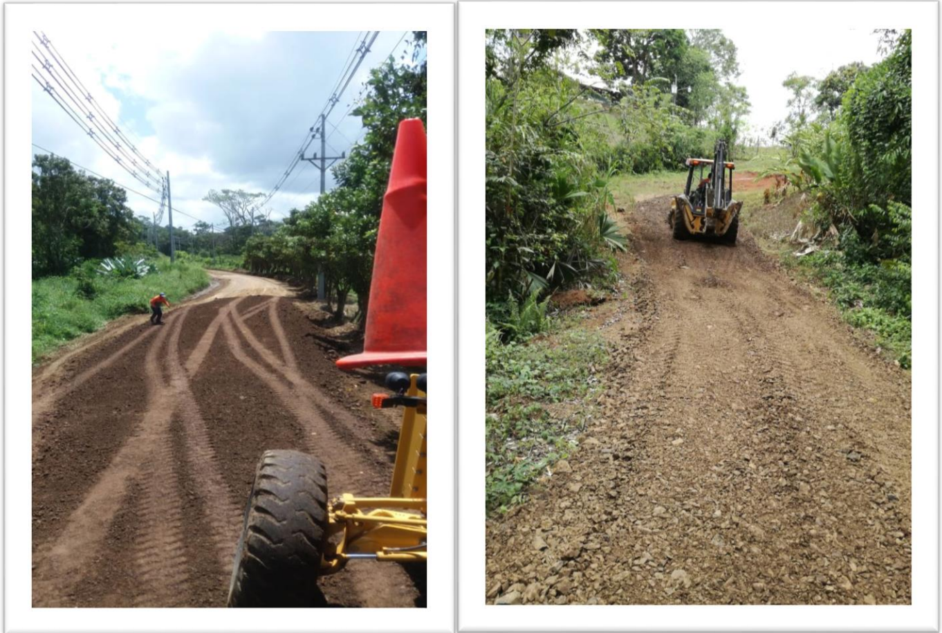
Las imágenes corresponden a trabajos realizados en calle Río Seco y calle Tárcoles
